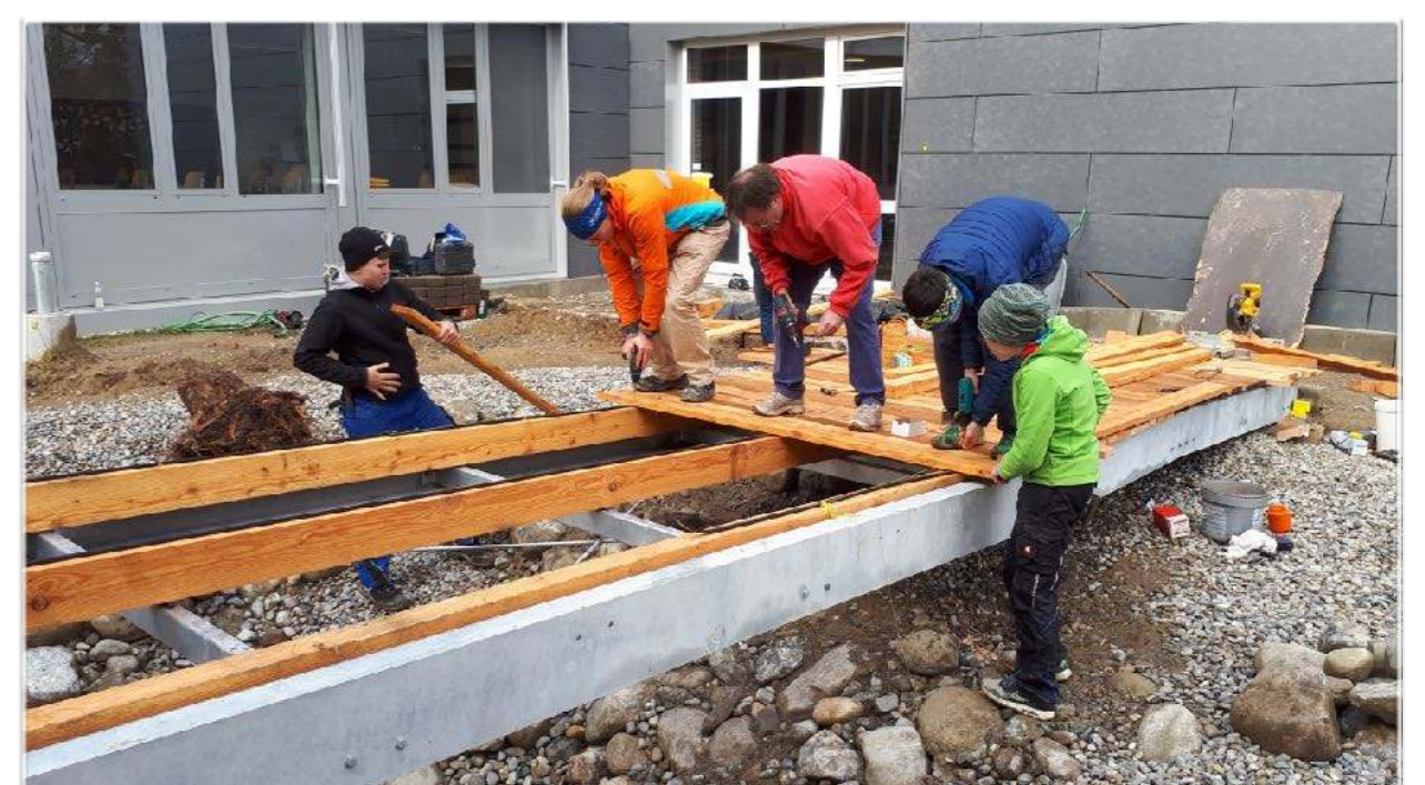
Bauphase mit engagierten Mitwirkenden
